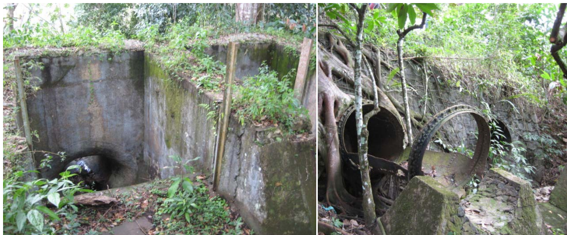
Figura 5 - Local onde a água saía do canal de concreto (à esquerda) e entrava nos dutos metálicos que alimentavam os geradores (à direita).
