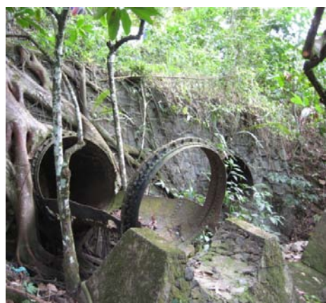
Figura 4 - Local onde a água saía do canal de concreto (à esquerda) e entrava nos dutos metálicos que alimentavam os geradores (à direita). Esse local é chamado de “vertedouro” por uma pessoa que trabalhou na usina.
