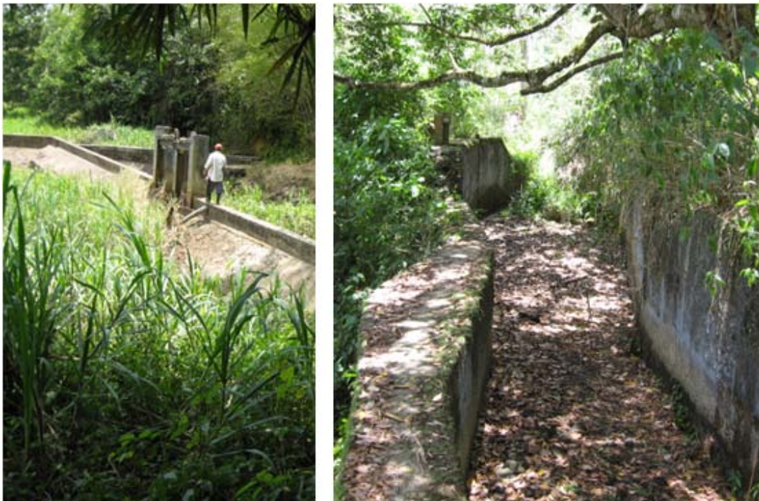
Figura 4: A) À esquerda vista da barragem da Usina do Almada na Fazenda Bonfim. B) À direita foto do canal de pedra na mesma fazenda. O fluxo de água da usina era controlado manualmente por comportas operadas por engrenagens.
