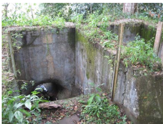
Figura 4 - Local onde a água saía do canal de concreto (à esquerda) e entrava nos dutos metálicos que alimentavam os geradores (à direita). Esse local é chamado de “vertedouro” por uma pessoa que trabalhou na usina.
