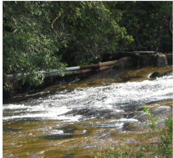
Figura 9 - A) Roda d'água da micro usina hidreletrica da fazenda Parafuso. B) Represa e canos de PVC no rio Caldeira para escoamento da água para a micro usina.
