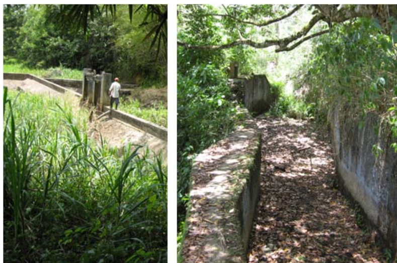
Figura 2 - A) À esquerda vista da barragem da Usina do Almada na Fazenda Bonfim. B) À direita foto do canal de pedra na mesma fazenda. O fluxo de água da usina era controlado manualmente por comportas operadas por engrenagens
