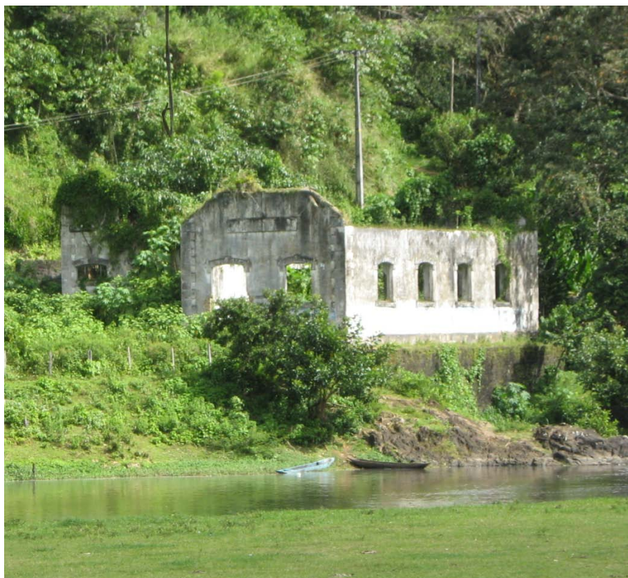
Figura 7: Ruínas da Usina do Almada
