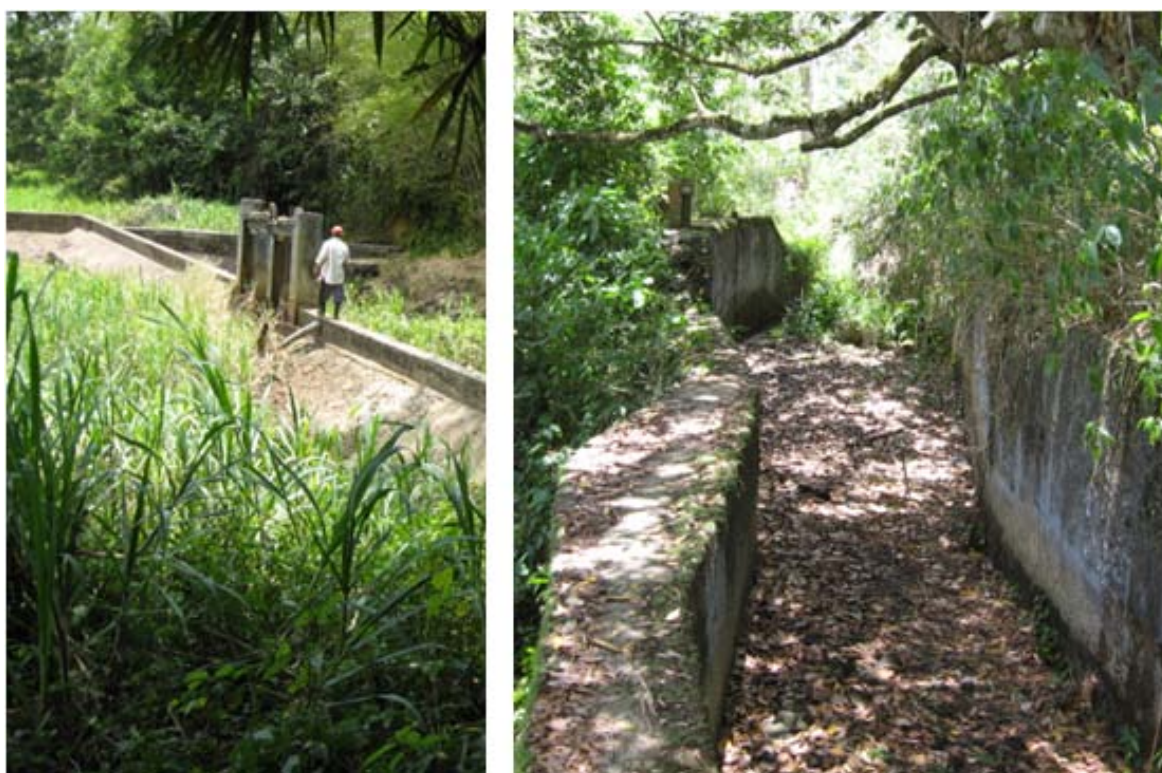
Figura 3 - À esquerda vista da barragem da Usina do Almada na Fazenda Bonfim e à direita foto do canal de pedra na mesma fazenda. O fluxo de água da usina era controlado manualmente por comportas operadas por engrenagens.
